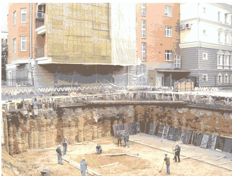
Рис. 1. Грунтоцементное ограждение бортов котлована, устроенное предприятием «ИнжПроектСтрой» с применением струйных технологий
